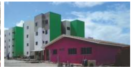
Conjunto Mércia de Albuquerque: em construção
